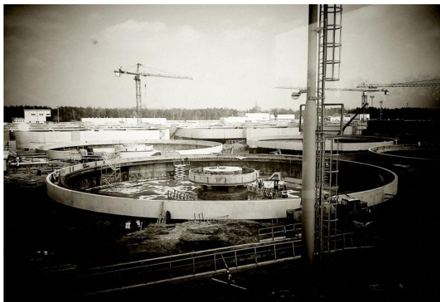
Fot: Budowa oczyszczalni Czajka
