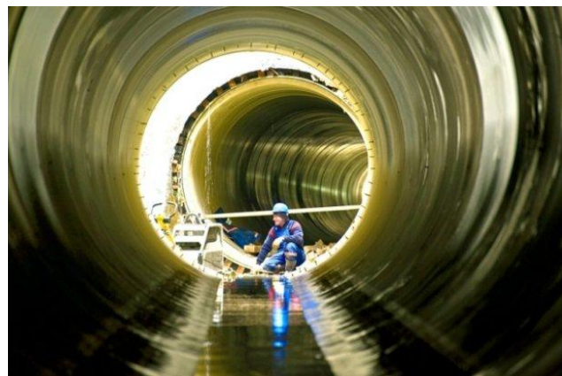
Fot: Budowa kolektora do oczyszczalni Czajka
